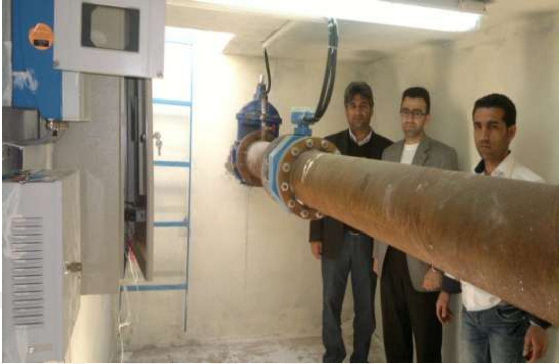
Şekil 4.9. Efes ölçüm odası debimetre ve basınçölçer montajı.
