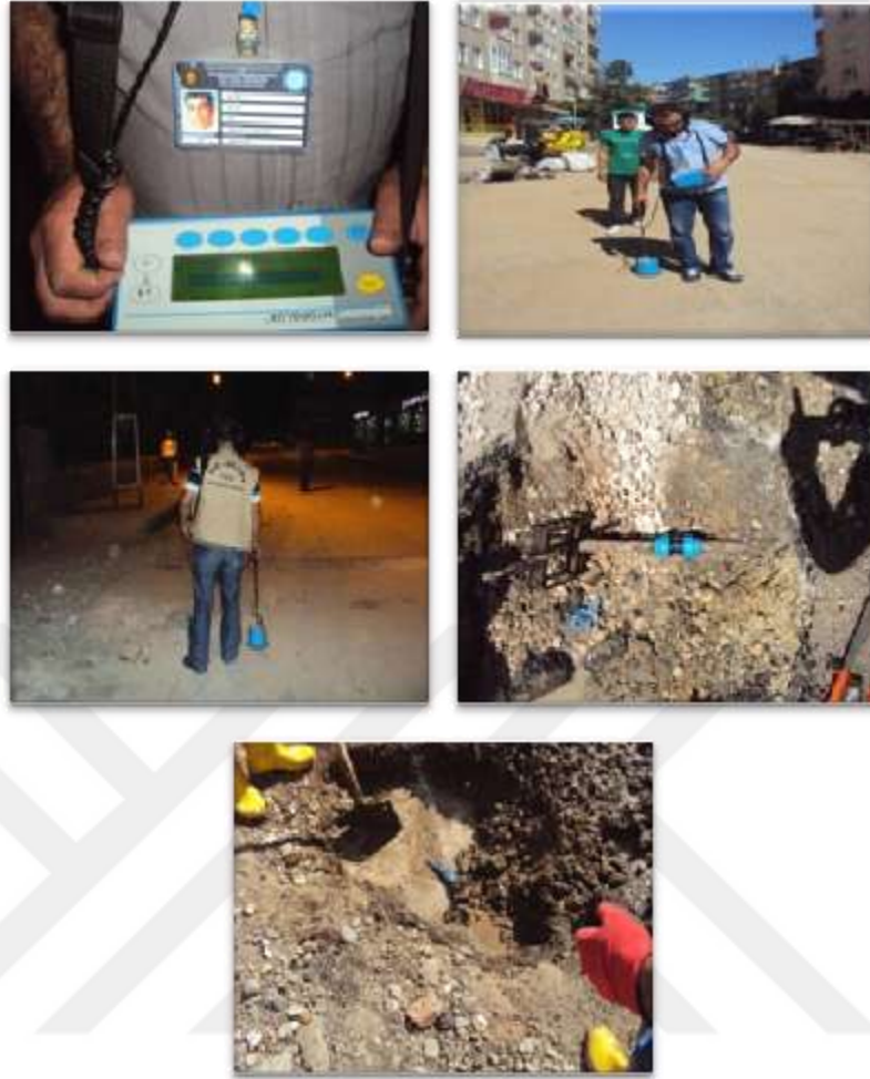
Şekil 4.13. Efes DMA bölgesi sızıntı tespiti ve onarım işleri.
