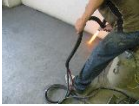
Şekil 3.7. Alev sprej yöntemiyle zeminin epoksi kaplanması [17]
