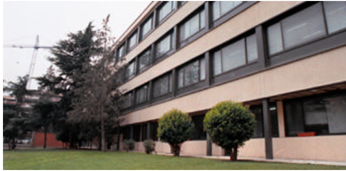
Figura 27. Fachada principal del IES Terrassa
