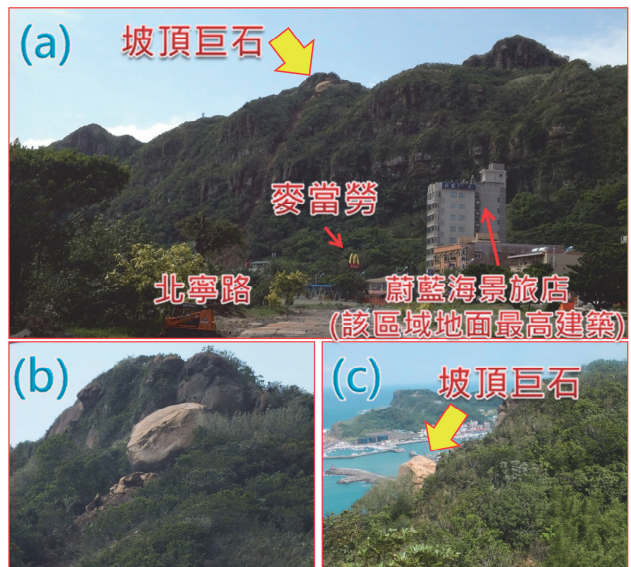
圖 8 八斗子落石災害坡頂殘留巨石 Fig.8 The residual stone on cliff
