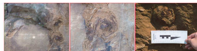
圖 13 崩壁之上之結核塊體
