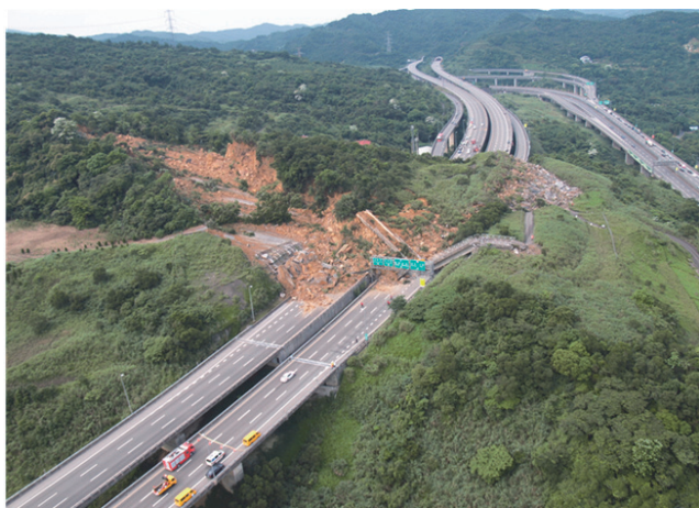
圖 1 國道三號於 3.1K 處於 2010 年 4 月 25 日發生之大規模滑動照片（資料取自國家防災科技中心（2010），本照片乃由空中勤務總隊拍攝）
