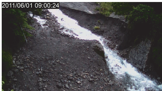
(d) 壩體工程拆除完成 (2011/06/01)
