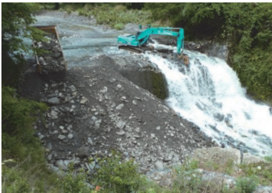
(b) 開始壩體拆除工程 (2011/05/25)
