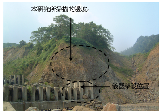
圖 9. 研究區位現地狀況 Fig.9 Location of 3D laser scanning
