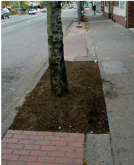
圖 1. Rainier 街路側區域上的加強性樹坑 Figure 1. Tree pit enhancement of Rainier Ave.
