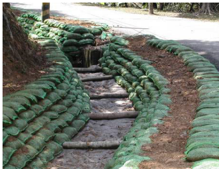
圖 7c. 坡趾掘溝排水 (5) Figure 7c. Ditch at toe (5).
