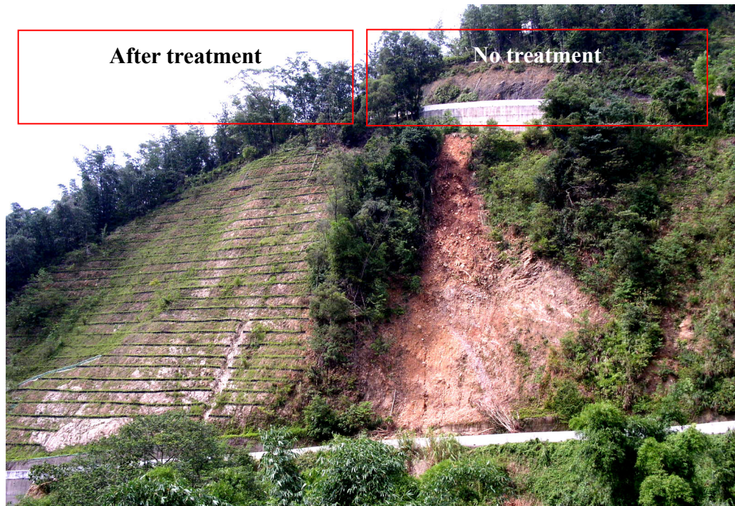
圖 9. 邊坡進行沖蝕控制處理與未處理影響比較 (2)
