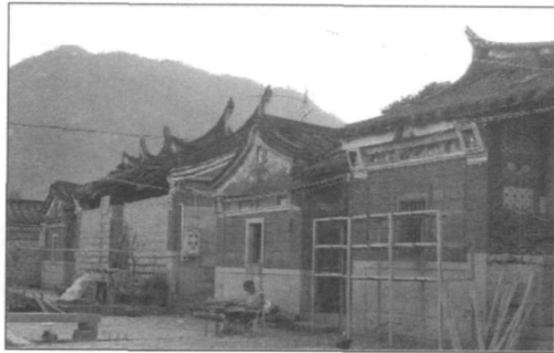
图4 厦门同安同字住宅
