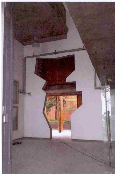
图9 洞口后的建筑空间(自摄)
