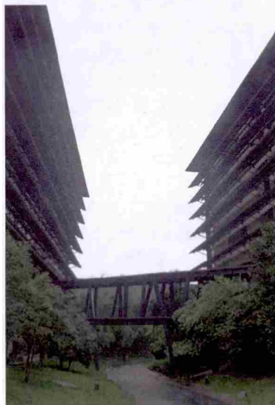
图10 建筑间的连廊(自摄)
