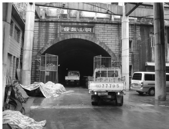
图1 钟鼓山隧道入口
