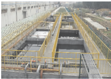
图 2 人工湿地污水站生化工艺
