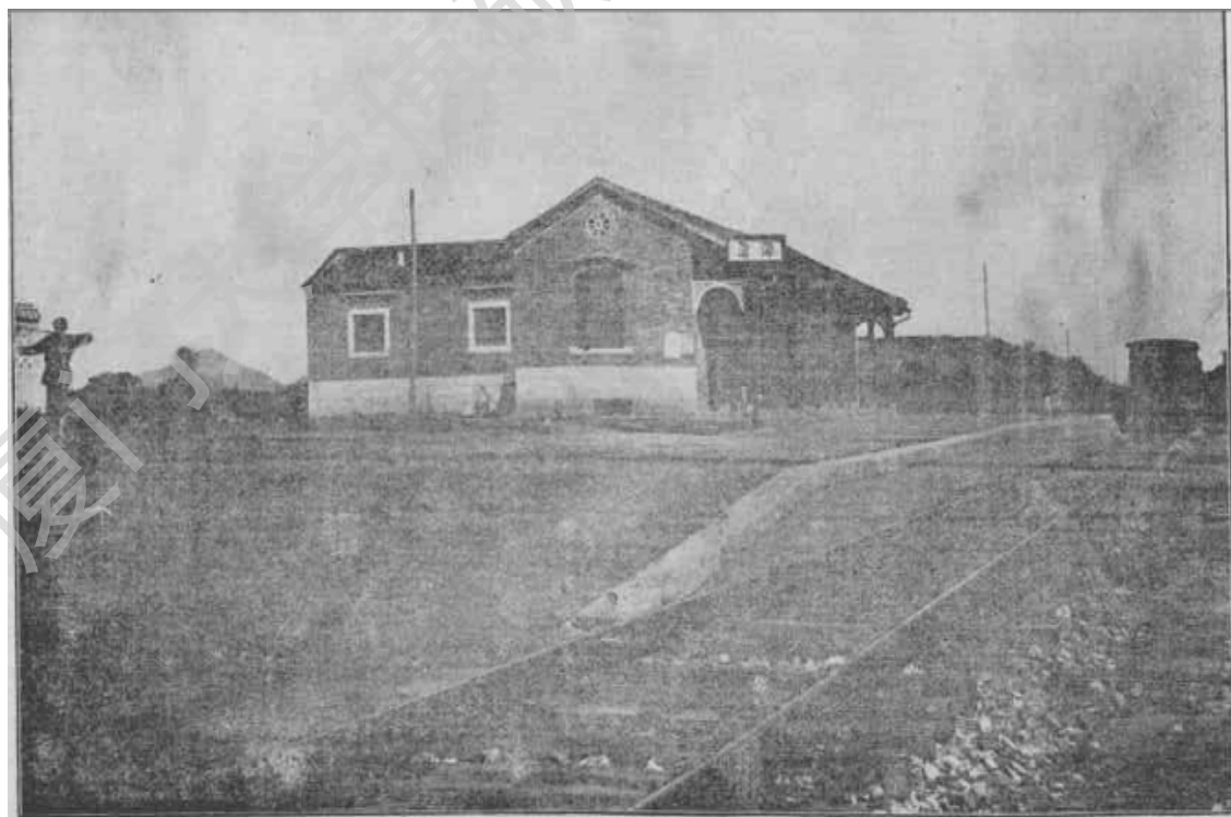
附图 3-2-2：漳厦铁路嵩屿车站
