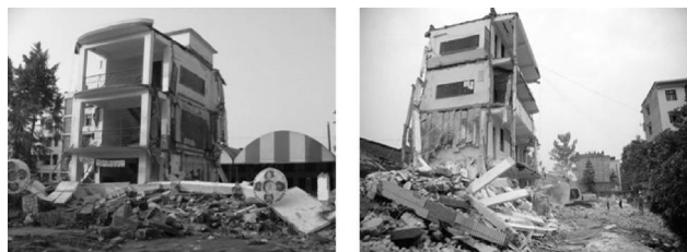
图1 中小学校建筑破坏严重
