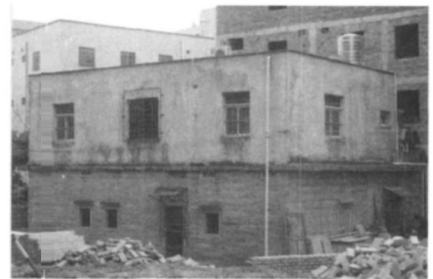
图3 石加砖混结构房屋 (厦门海沧区西边村)
