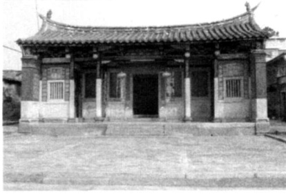
图4 砖木结构房屋(厦门翔安区大嶝)
