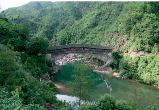
14 寿宁县杨梅溪桥
