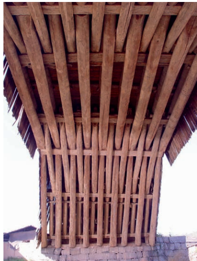
12 万安桥下梁架结构
