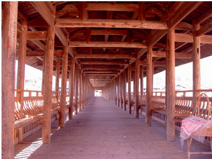
13 万安桥上梁架结构
