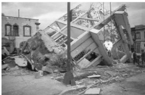
图1 楼房震后垮塌
