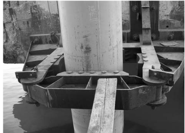
Рис. 4. Серьга пала, закрепленная к пирсу на судоремонтном заводе
