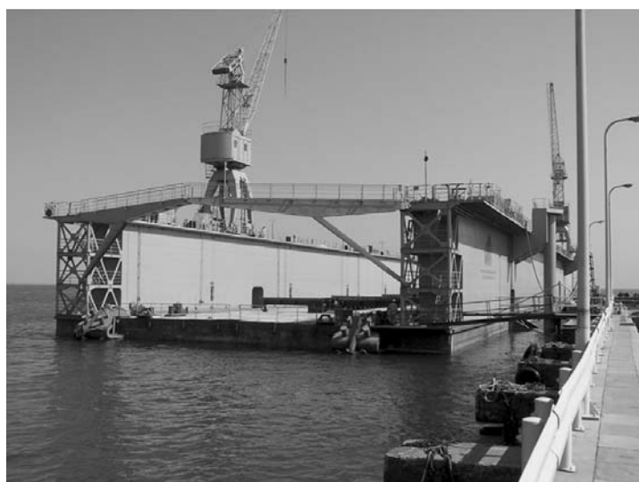
Рис. 6. Композитный плавучий док с установленными палами
