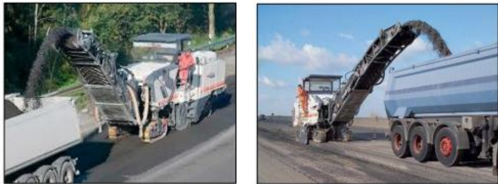
Figura 03. Máquinas Fresadoras o perfiladoras. En proceso de reciclado de material de pavimentos envejecidos, en la carretera Nacional PE 3SC Jauja – Huancayo, año 2014. Fuente: Chumán, J. 2017, p. 105
