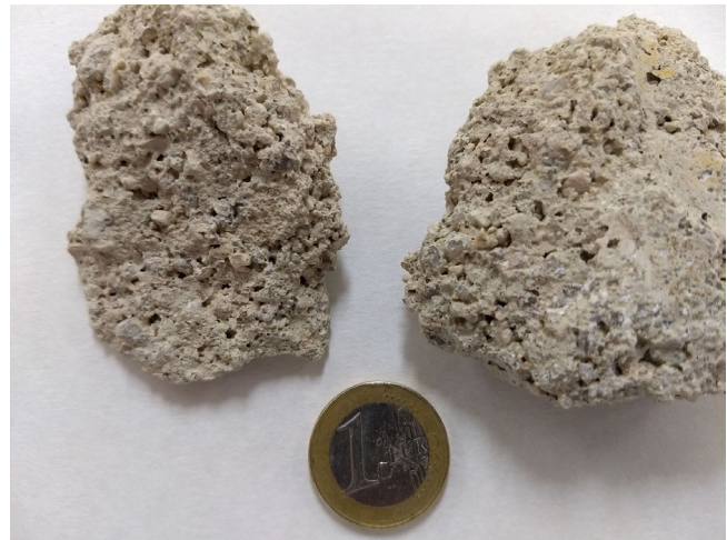
Figura 5.- Apariencia del hormigón de la zapata D55
