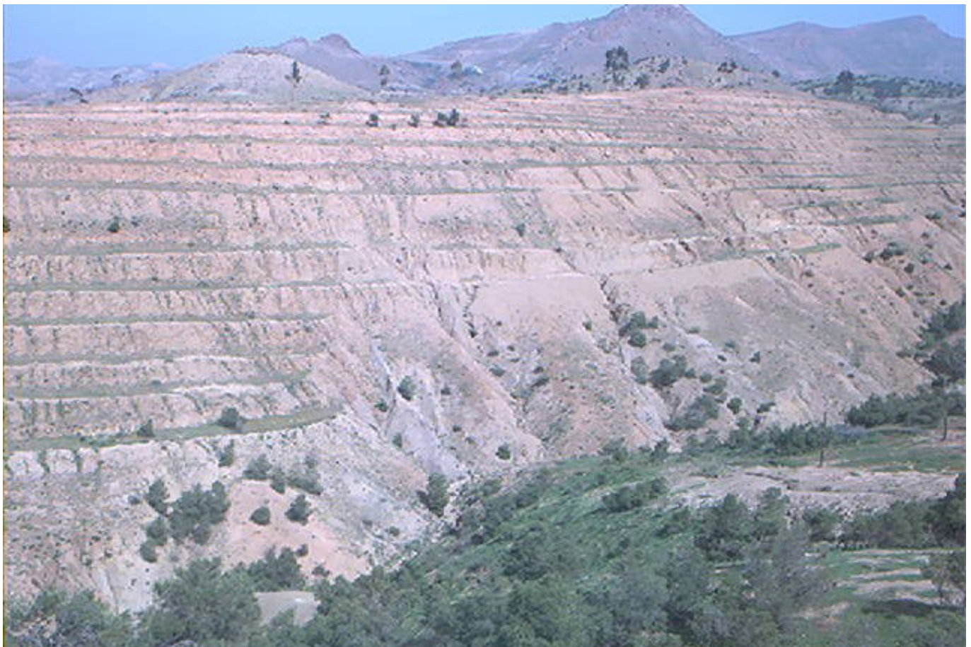
Photo 1: Développement du ravinement suite à l'installation d'un réseau de banquettes de diversion sur terrain marno-calcaire dans le bassin versant de Sidi Mhamed Benaouda dans la Wilaya de Relizane (Algérie). © INRF/ M. Arabi
