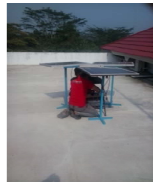
Gambar 2. Pengujian Baterai dan Panel Surya
