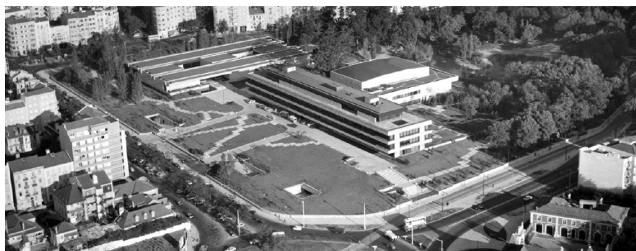
[21] Vista aérea del conjunto, 1969
