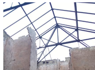
Detalle cercha edificio de viajeros de Pitarra. Foto propia.
