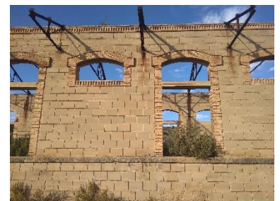
Detalle de huecos del edificio de mercancías. Foto propia.
