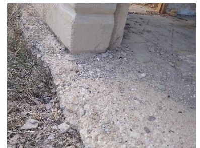
Apoyo del murete en la cimentación. Edificio de viajeros. Foto propia.
