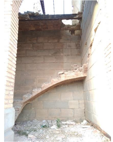
Tramo de escalera de la estación de Pitarra. Foto propia.
