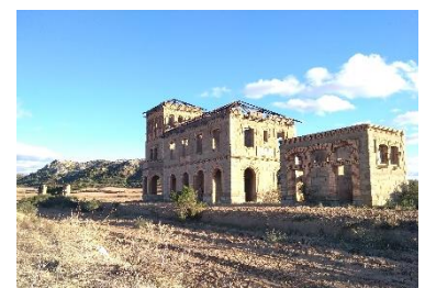
Edificio de retretes de la estación de Pitarra; carece de hastiales, por lo que se trataría de cubierta a cuatro aguas. Foto propia.
