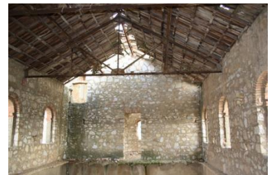
Interior de la estación de Valdeconejos, construida completamente de piedra natural. Foto Pedro Verdejo.
