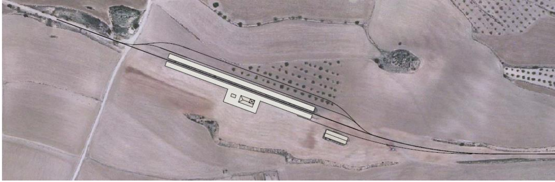
Reconstrucción hipotética de funcionamiento y disposición de las vías en la estación de Pitarra, del término municipal de Alcorisa, según los restos de muretes encontrados. Simulación realizada por Pedro Verdejo en su tesis Estaciones intermedias de ferrocarril.
