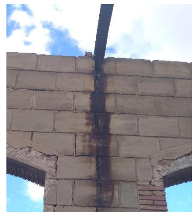
Detalle del apoyo de la cercha metálica de cubierta directamente sobre el paramento de muro de los muelles de mercancías. Foto propia.
