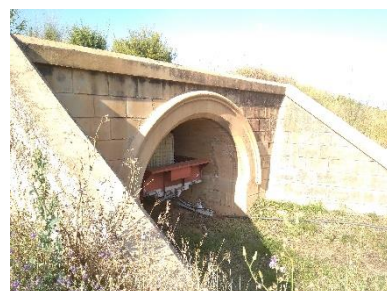
Pequeño viaducto del término municipal de Alcorisa; en la actualidad es usado para resguardar maquinaria agrícola. Foto propia.
