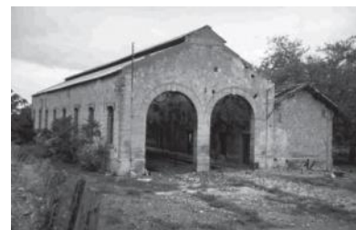
Cocheras de Chinchilla. Foto Fundación de los ferrocarriles españoles.
