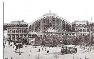
Fachada principal de la estación de Atocha de Madrid. parkingatochamadrid.es
