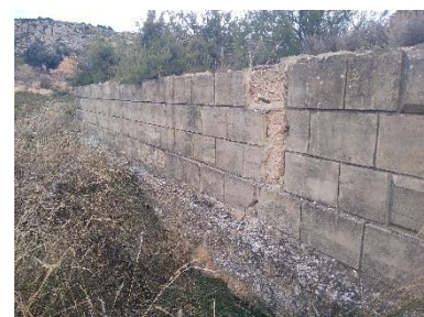
Murete exterior de los muelles de mercancías de la estación de Alcorisa donde se aprecia en su base el zócalo de cimentación formado por bolos de piedra caliza y mortero. Foto propia.
