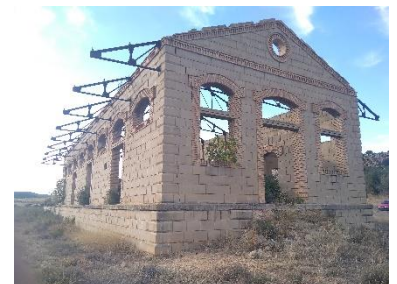
Edificio de muelles de mercancías. Composición del zócalo y muro. Foto propia.
