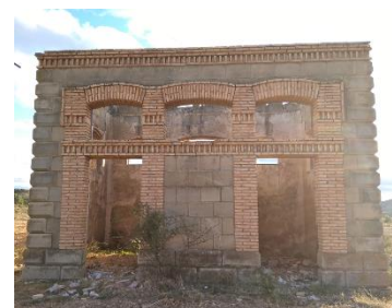
Fachada Norte edificio de retretes de Pitarra. Foto propia.
