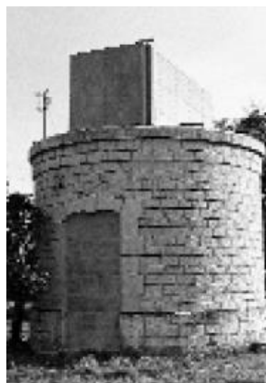
El depósito de agua de la estación, fundamental para los trenes cuando funcionaban con caldera de vapor. La llegada del ferrocarril, en Historia de Monreal del Campo, Monreal, 2006, p. 189-200 (Serafin Aldecoa Calvo).
