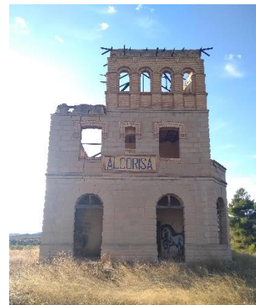
Fachada Este estación de Alcorisa. Foto propia.
