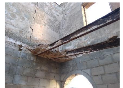
Restos del forjado de la estación de Pitarra. Foto propia.
