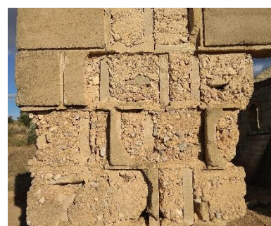
Composición muro. Casilla de Calanda. Foto propia.
