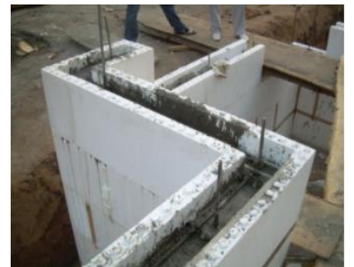
Ejemplo de construcción con bloques de poliestireno expandido. https://arquigrafico.com/poliestireno-expandido-ventajas-de-su-uso-en-la-construccion/
