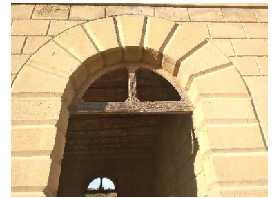
Restos del arco de carpintería de uno de los ventanales del edificio de viajeros de Alcorisa. Foto propia.
