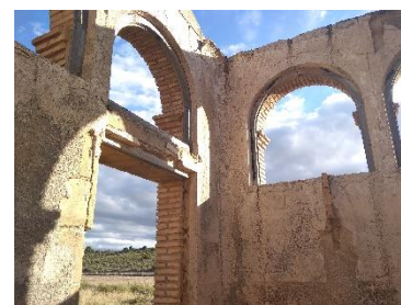
Detalle del interior de los retretes; llega a apreciarse la tabiquería interior separatoria de urinarios. Foto propia.
