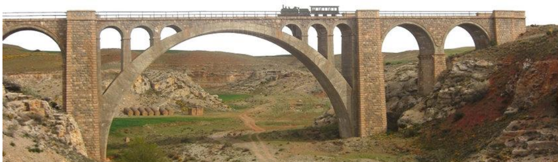
Viaducto sobre la Rambla de los Canales. Caminos frustrados hacia la prefabricación arquitectónica.
