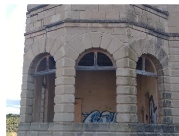
Triple ventanal del módulo saliente del edificio de viajeros. Arcos continuos de piezas de piedra artificial unifican el conjunto. Foto propia.
