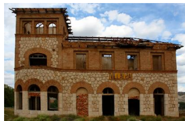
Edificio de viajeros de la antigua estación de ferrocarril de Villalba Baja. http://miscelaneaturulense.blogspot.com/2011/07/julio2011miscelanea-estacion-inconclusa.html
