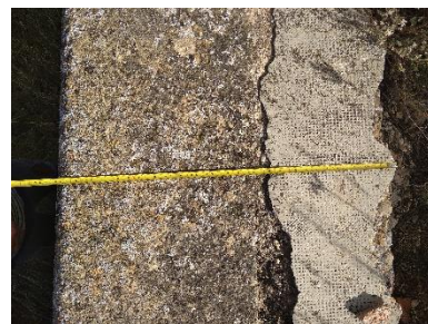
Medida del espesor del muro en la base. 60 cm de espesor aproximadamente. Foto propia.
