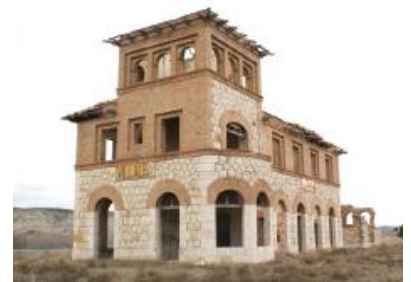
Estación intermedia de Villalba Baja. Edificio de viajeros de la línea intermedia de ferrocarril Teruel - Alcañiz. Google maps.
