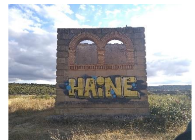
Pintadas sobre el edificio de retretes de la estación de Alcorisa. Foto propia.
