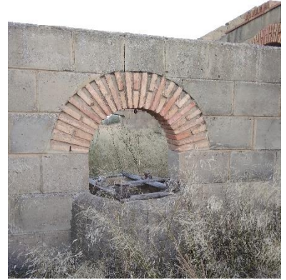
Pozo de agua y murete divisorio de viviendas en la casilla de Calanda; Foto propia.
