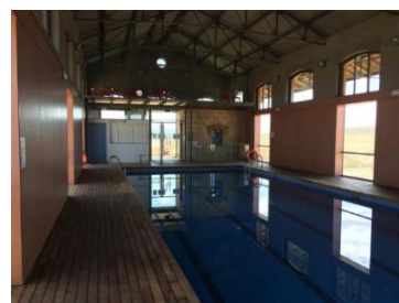
Interior del edificio de muelles de Perales de Alfambra tras ser reconvertida en piscina cubierta. Heraldo de Aragón. www.heraldo.es/noticias/aragon/teruel/2014/09/28/estacion-fantasma-perales-del-alfambra-vuelve-la-vida-312552-2261128.html
