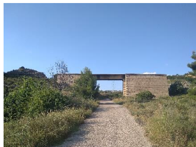
Viaducto de término municipal de Alcorisa Foto propia.
