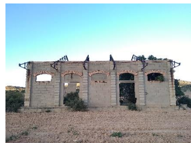
Fachada muelles de Pitarra. Visibles las pilastras de apoyo de las cerchas metálicas de cubierta. Foto propia.
