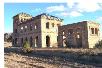
Perspectiva del edificio de retretes de Pitarra. Foto propia.
