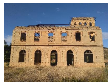
Fachada Sur de la estación de Alcorisa. Foto propia.
