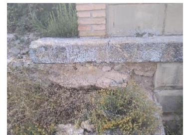
Foto donde queda reflejada la composición de la cimentación. Foto propia.
