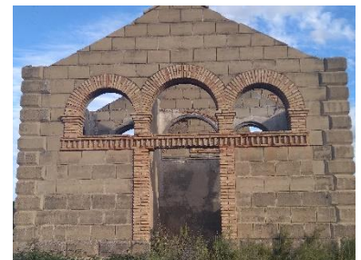
Recercado de la puertas y ventanas del edificio de retretes de la estación de Alcorisa. Foto propia.
