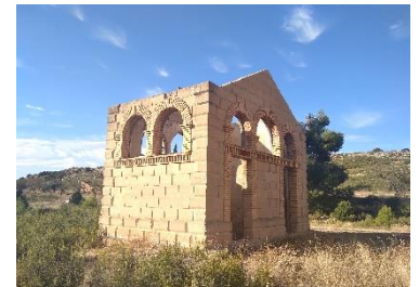
Edificio de retretes de la estación de Alcorisa; nótese la cubierta a dos aguas. Foto propia.
