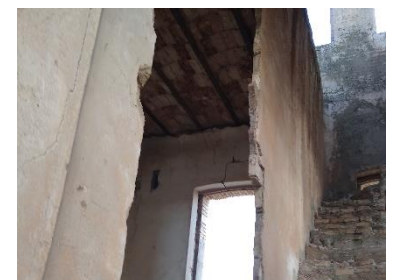
Forjado planta torreón estación de Pitarra. Foto propia.
