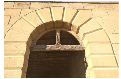
Piezas de hormigón con forma de dovelas para rematar el hueco y arco de puerta. Foto propia.
