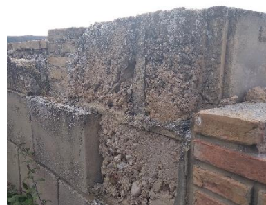
Composición muro característicos de las construcciones, piezas en L prefabricadas rellenas con mortero. Foto propia.
