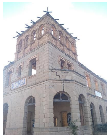
Torreón de la estación de Alcorisa. Foto propia.
