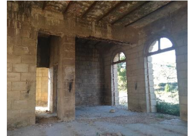
Viga del interior del edificio de viajeros. Foto propia
