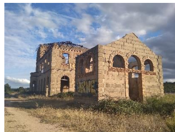
Estación de ferrocarril de Alcorisa. Vista donde se observa la semejanza constructiva y lingüística del edificio de viajeros con el de retretes. Foto propia.
