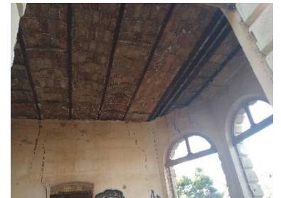
Triple viga de sujeción del lado correspondiente al balcón, sobre el que se asienta el torreón. Fotp propia.
