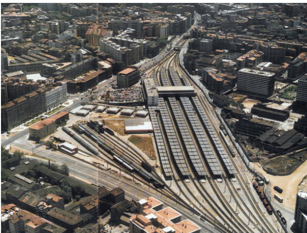
Figura 20. Foto aérea de la estación del Portillo. 1990.
