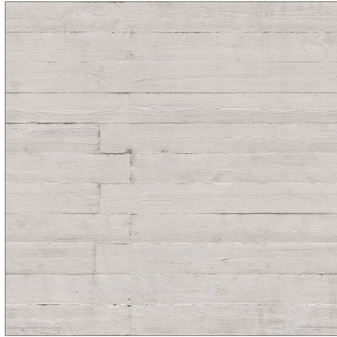
P1 - Hormigón estructural visto encofrado de manera tradicional con tablas de madera de pino aserrada y sin tratamiento exterior posterior.
