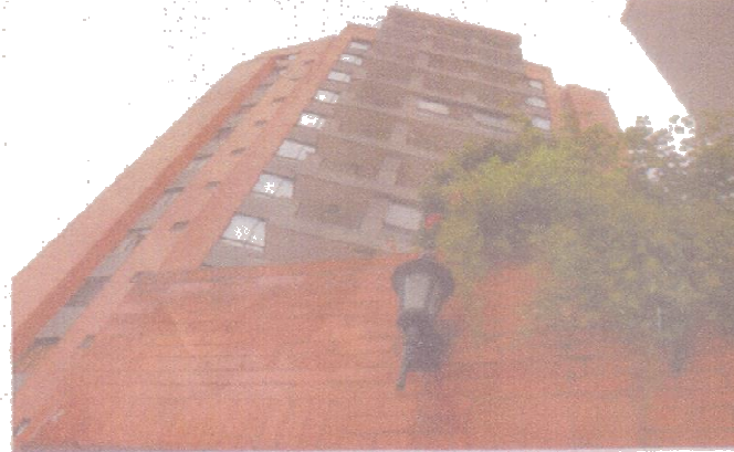
Una torre residencial que muestra influencia de Salmons en el barrio San Fernando, zona del antiguo centro del departamento.
