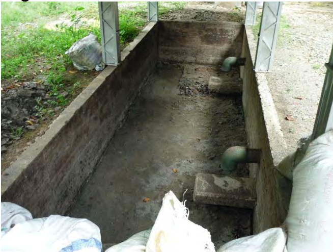
Figura 27. Pozo receptor y cribado
