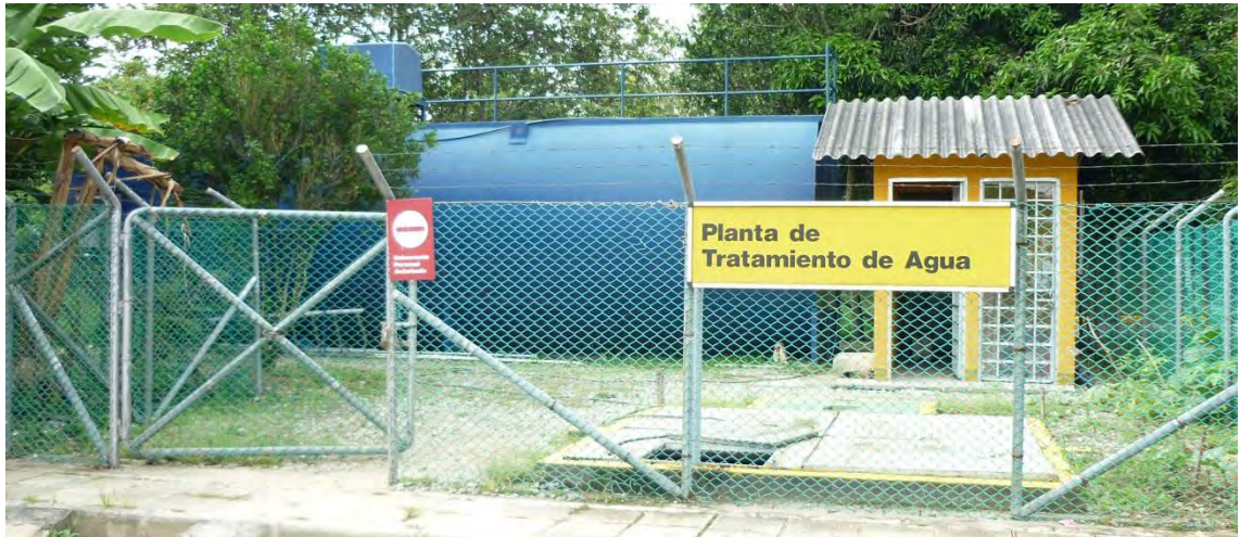
Figura 12. Fotografía de la PTARD del aeropuerto El Edén de Armenia
