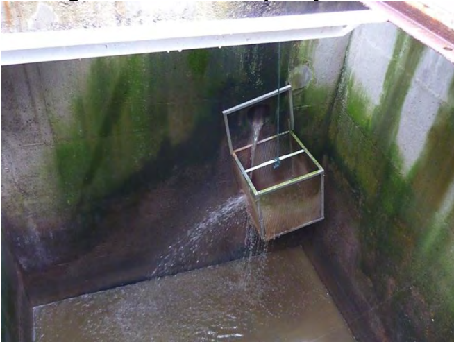
Figura 27. Pozo receptor y cribado
