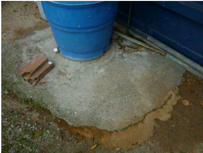
Figura 31. Presencia de hormiguero en cemento de la PTARD
