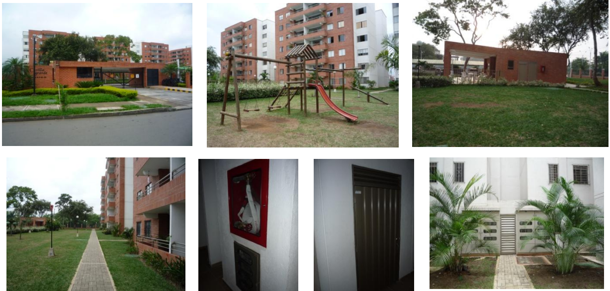
Figura 9. Imágenes de la unidad residencial Castilla Grande, algunos espacios a intervenir, arriba: portería, zona de juegos y zona común, abajo: torres A,B,C, gabinete contra incendios y contadores de agua, puerta de acceso a caja de teléfonos, contadores de energía
