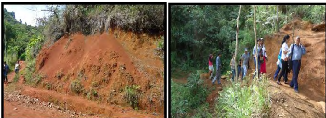
Figura 18. Fotografía de erosión del suelo
