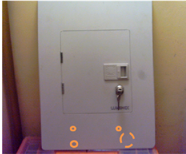
Área don de se perforara la caja de breakers
