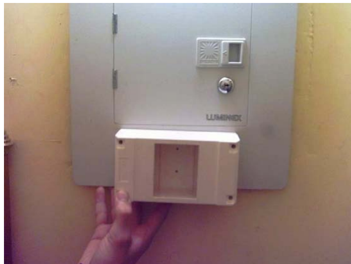
Figura 35. Instalación del Dispositivo DOMOTRONIC
