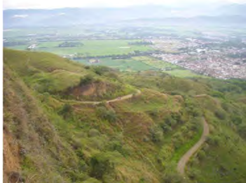
Figura 8. Loma del Derrumbado
