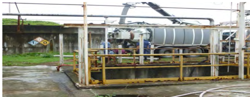
Figura 15. Imagen sub programa de Mantenimiento de planta
