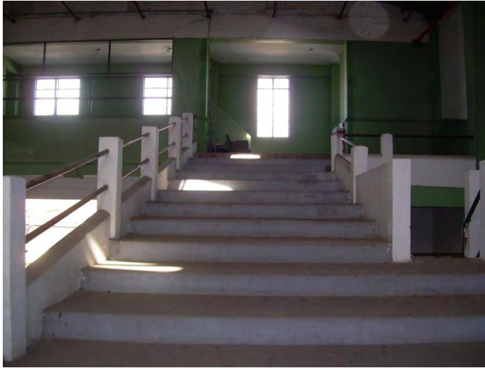
Figura 16. Zona sub utilizada, segundo nivel ubicada en la bodega de mayor
