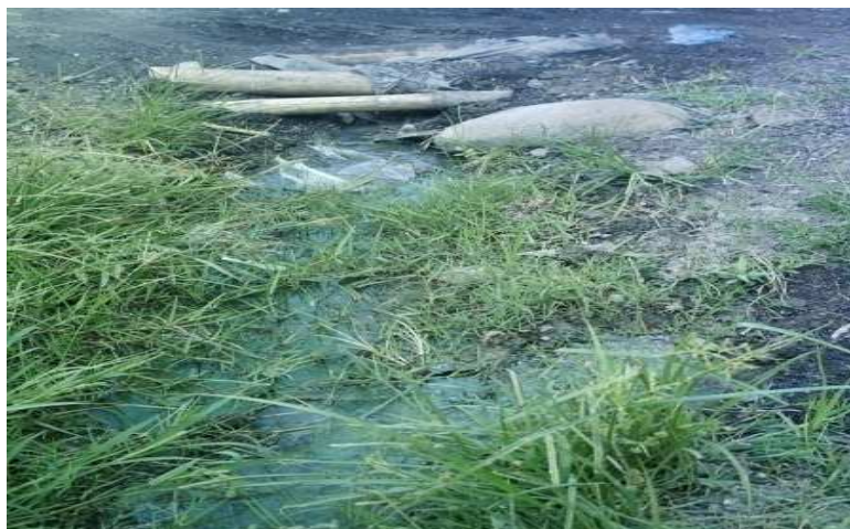
Foto 2. Obstrucción de canales.
