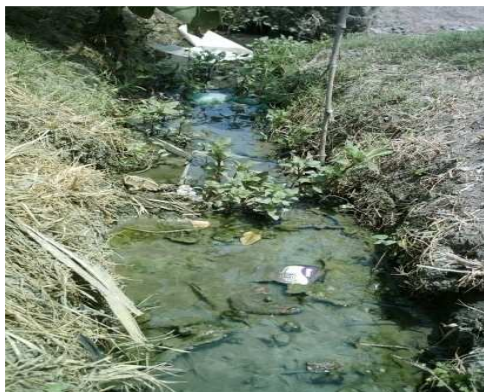
Figura 13. Obstrucción de canales por disposición de residuos.
