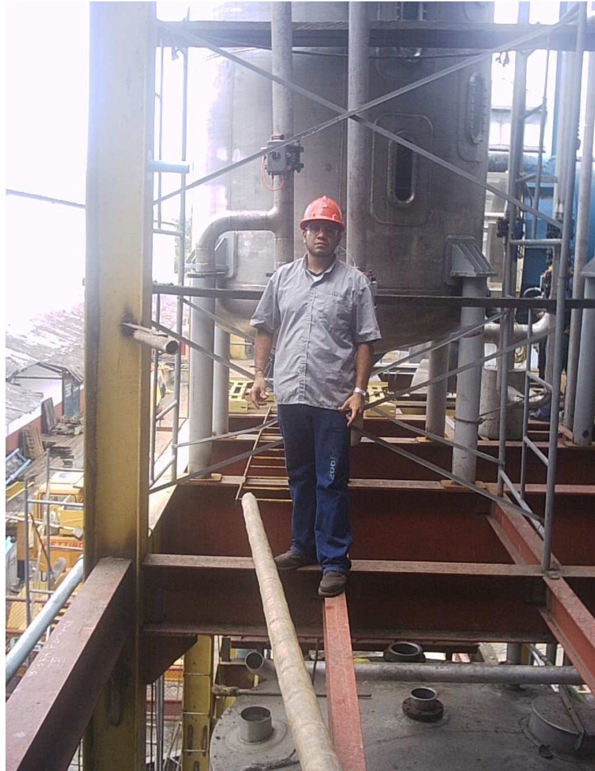
Figura 3. Construcción de los filtros de lecho profundo
