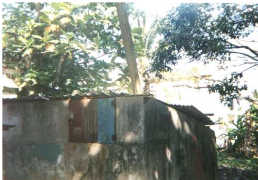
Figura 15. Sistema captación de agua lluvia
