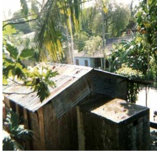
Figura 5. Vivienda del sector Loma- Shingle Hill
