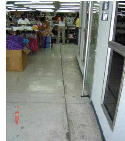
Foto 33. DESPUES Pasillo principal Terminación - Oficinas
