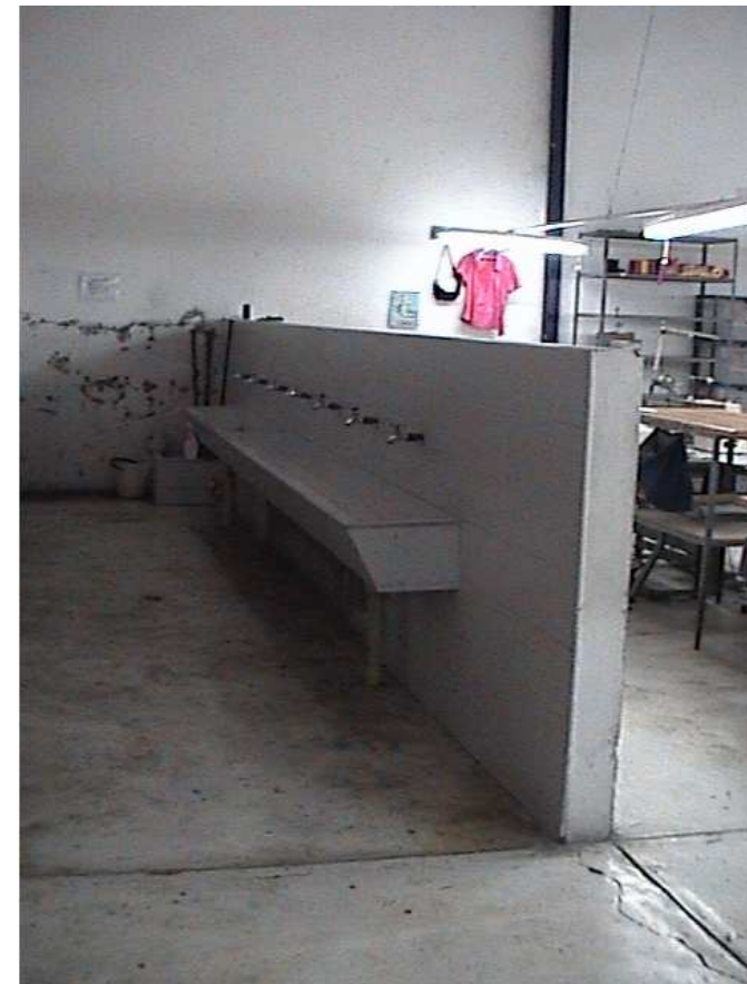
Foto 37. DESPUES Baños despejados
