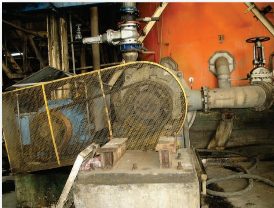
Figura 26. Foto del conjunto Bomba –Motor, sistema Tanque de Jugo Encalado
