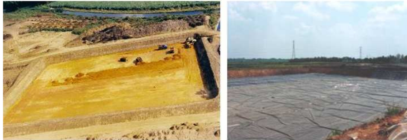
Nueva lagunas de almacenamiento de lixiviados, marzo de 2003.
