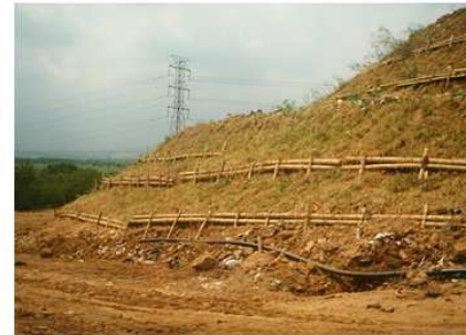
CONSTRUCCIÓN DE TRINCHOS PARA EVITAR EROSIÓN
