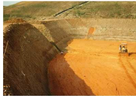
ADECUACIÓN DE ZANJAS PARA COLOCACIÓN DE TUBERÍA DE CONDUCCIÓN DE LIXIVIADOS
