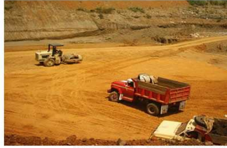
COLOCACIÓN DE 50 cm DE ARCILLA COMPACTADA
