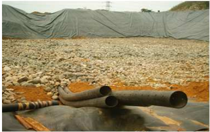
COLOCACIÓN TUBERIA DE DRENAJE
