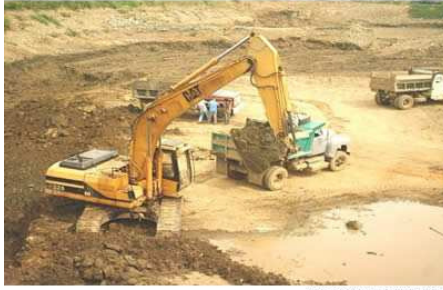
REMOCIÓN DE TIERRA
