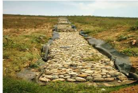
CONSTRUCCIÓN DE SISTEMA DE DRENAJE DE AGUAS LLUVIAS
