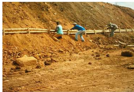
CONSTRUCCIÓN DE TRINCHOS PARA EVITAR EROSIÓN
