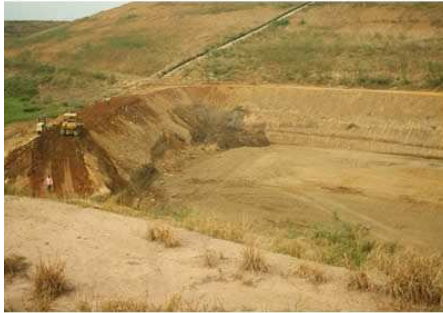
CONSTRUCCIÓN DE DIQUES PERIMETRALES
