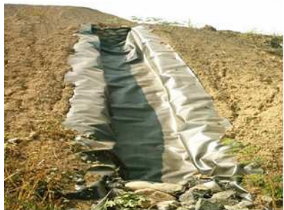
CONSTRUCCIÓN DE SISTEMA DE DRENAJE DE AGUAS LLUVIAS
