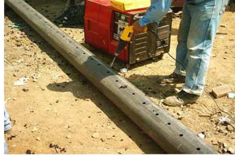
PERFORACIÓN TUBERIA PEAD
