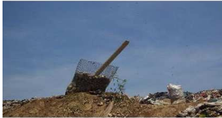
Chimeneas relleno transitorio, julio 20 de 2002
