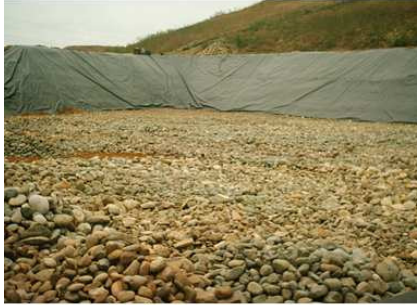
COLOCACIÓN DE 30 cm DE PIEDRA DE RIO
