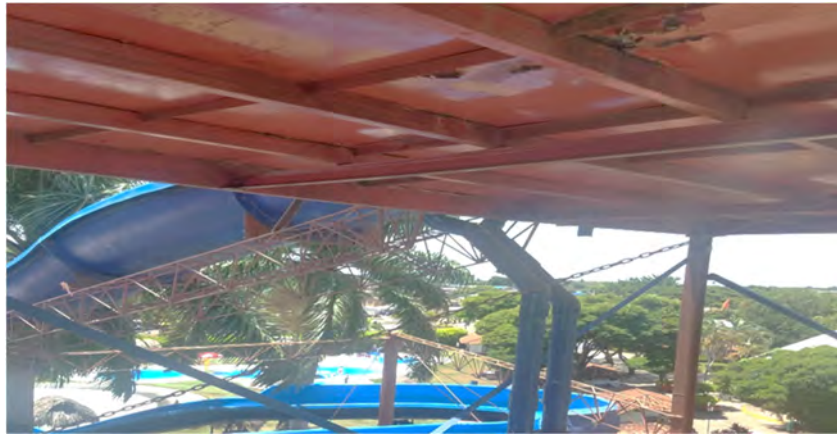
Fig. 42. Lámina metálica de la plataforma.
