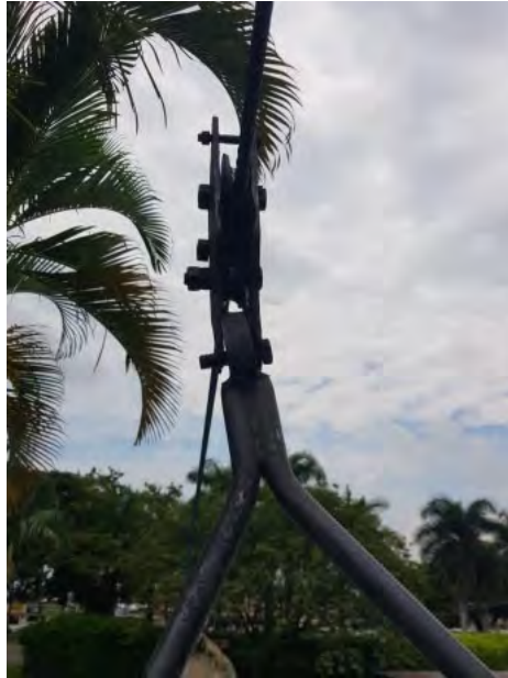
Fig. 51. Polea sin tuerca.
