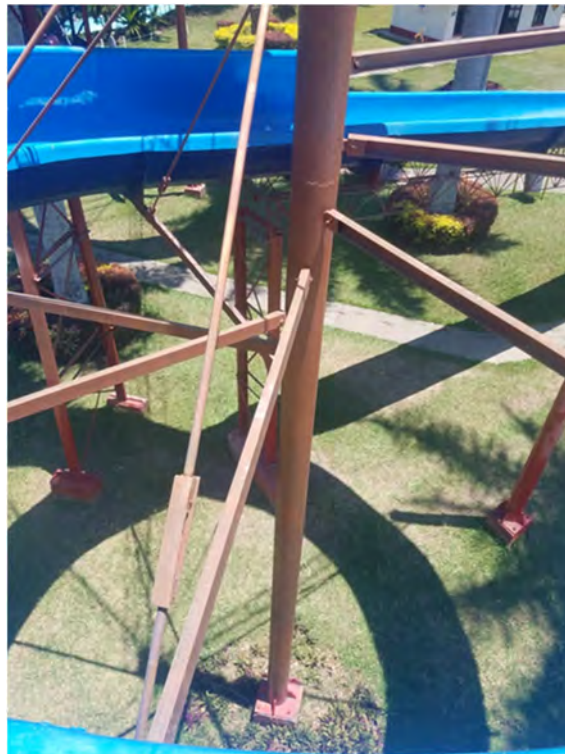
Fig. 18. Torre de soporte 3 para tobogán curvilíneo.
