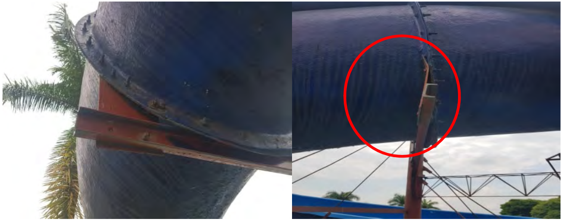
Fig. 45. Daño en una lámina del tobogán curvilíneo. (a) lamina doblada en fibra de vidrio. (b) vista lateral lamina doblada.
