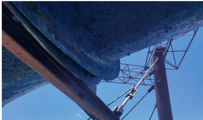
Fig. 17. Desajuste tobogán curvilíneo torre 2.
