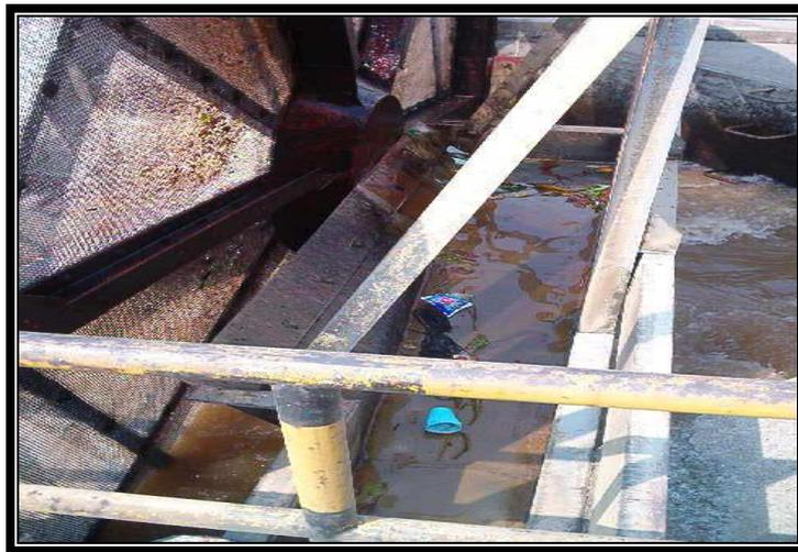
En los desarenadores de las Plantas Puerto Mallarino y Río Cauca hay presencia de residuos como material vegetal, textil y plástico, los cuales son recogidos por los equipos mecánicos y el restante por su pequeño tamaño es evacuado junto al material desarenado al río Cauca. En las Plantas Río Cali y La Reforma los
