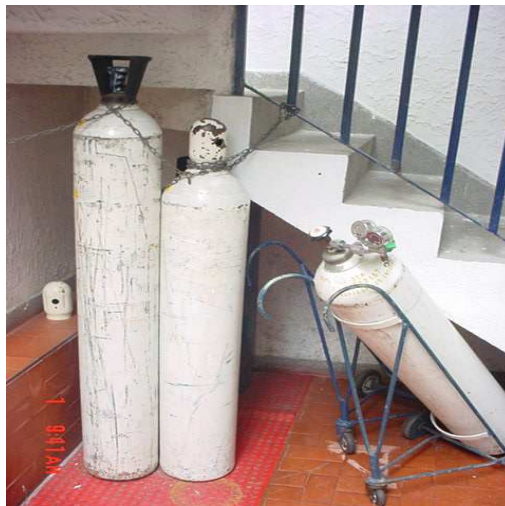
Figura 17. Almacenamiento de balas de oxígeno inadecuado, las balas no están identificadas
