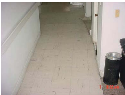
Figura 20. Piso en mal estado, guarda escoba inadecuado
