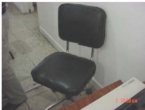
Figura 5. Silla inadecuada para trabajo, piso desnivelado en mal estado, guarda escobas no son en media caña
