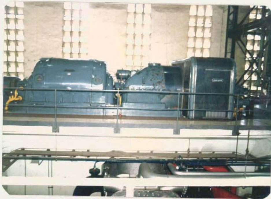
FIGURA 3. Alternador trifásico acoplado directamente a la turbina marca Brown Boveri de 41.250 KVA
