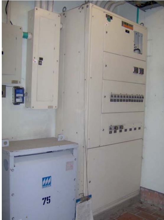
Foto 29. Tablero de contadores y transformador, edificio Bienestar piso 2
