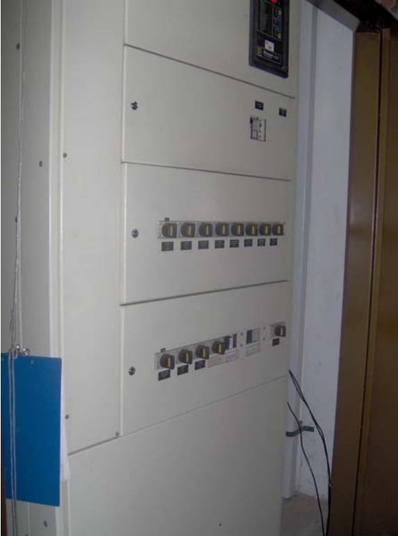
Foto 25. Tableros Auxiliares, Interruptor y Transformador Aulas 3 piso 1
