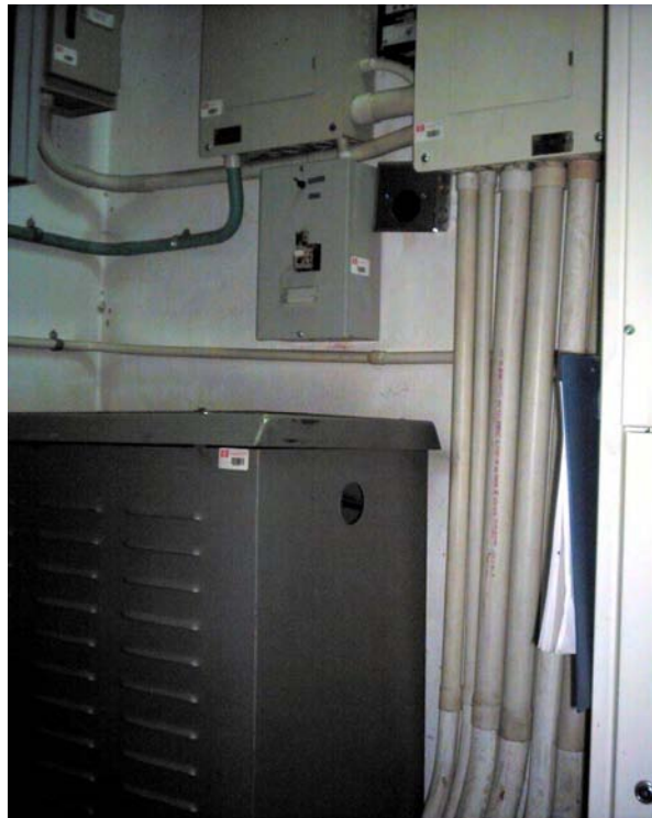
Foto 21. Transformador 50 Kva. Aulas 1 piso 1
