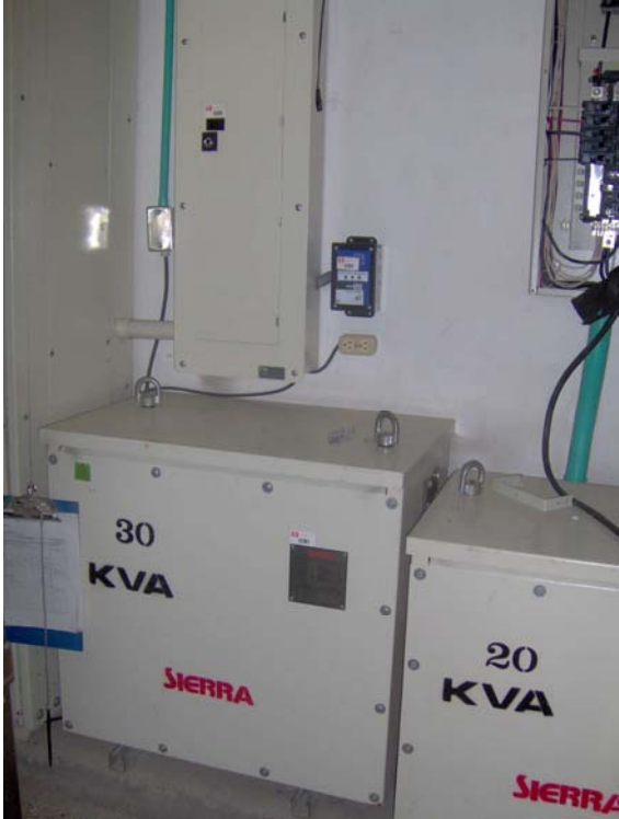
Foto 15. Tableros Auxiliares y transformadores Ed. central piso 1 lado norte
