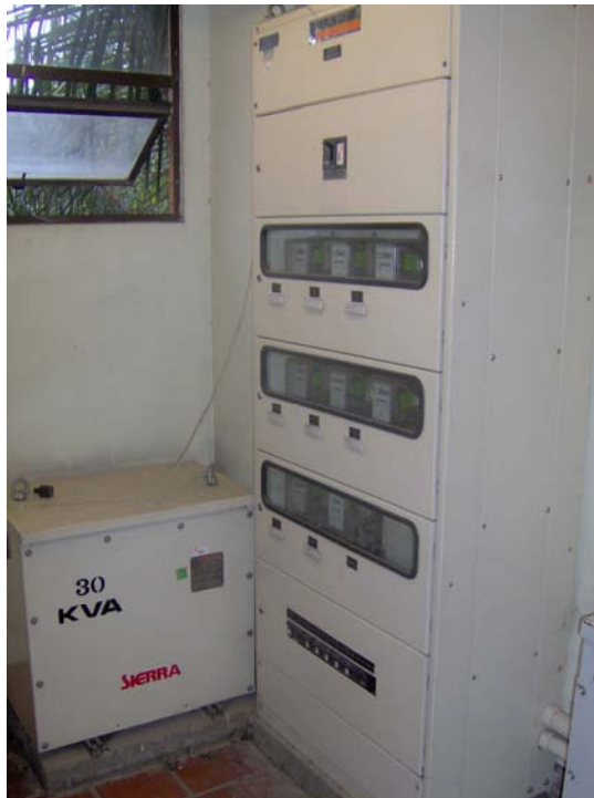
Foto 29. Tablero de contadores y transformador, edificio Bienestar piso 2
