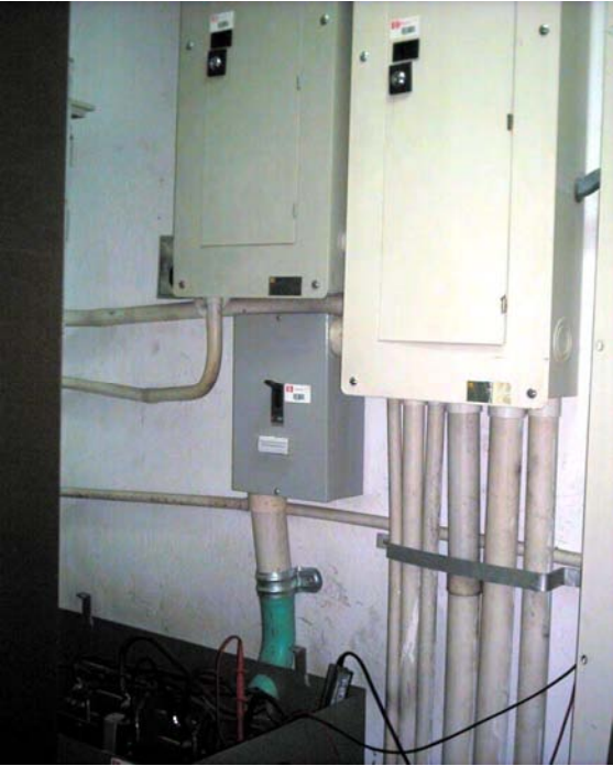
Foto 25. Tableros Auxiliares, Interruptor y Transformador Aulas 3 piso 1
