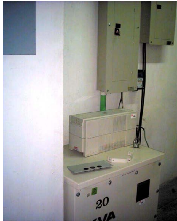
Foto 3. Transformador, tableros auxiliares y Ups, sótano lado sur
