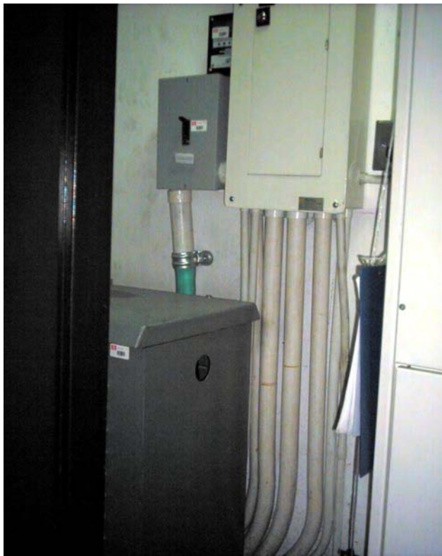
Foto 27. Tablero Auxiliar, Interruptor y Transformador Aulas 4 piso 1
