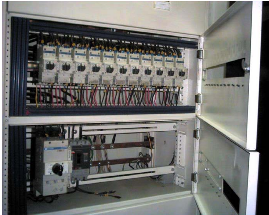
Foto 23. Tablero Auxiliar, e Interruptor Aulas 2 piso 1
