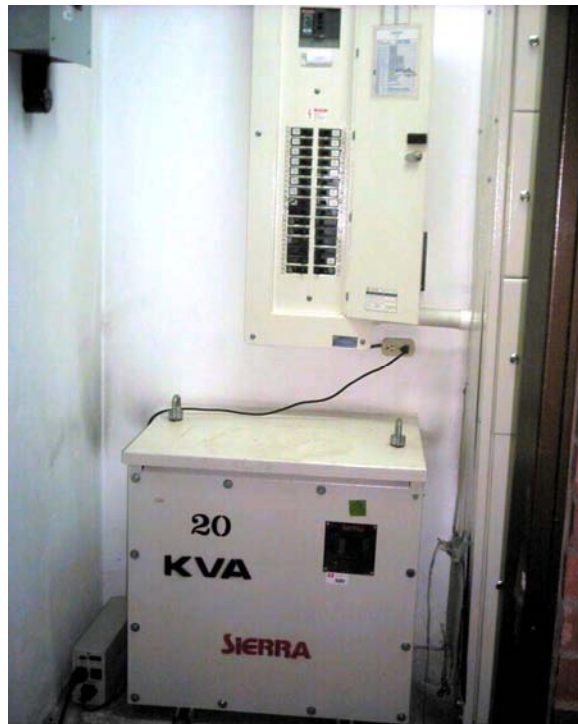
Foto 12. Tablero Auxiliar, transformador y ups Ed. central piso 3 lado sur
