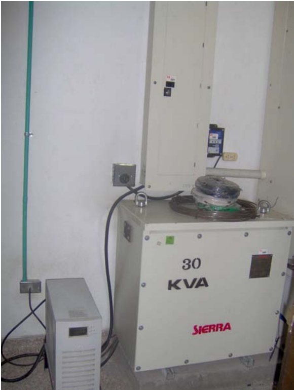
Foto 9. Tablero Auxiliar, transformador y ups Ed. central piso 1 lado sur
