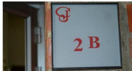
**4.4.5.3 Materiales.** El material utilizado en las señales actuales es un acrílico 2 mm con impresión directa a este, sin embargo diferentes sitios del Colegio han sido demarcados con señales hechas a mano en materiales diferentes con el fin de reemplazar las señales faltantes.
