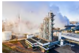
Fig. 2 Methanol plant at Södra Cell's mill in Månsterås, Sweden. (Photo: Södra Cell)
