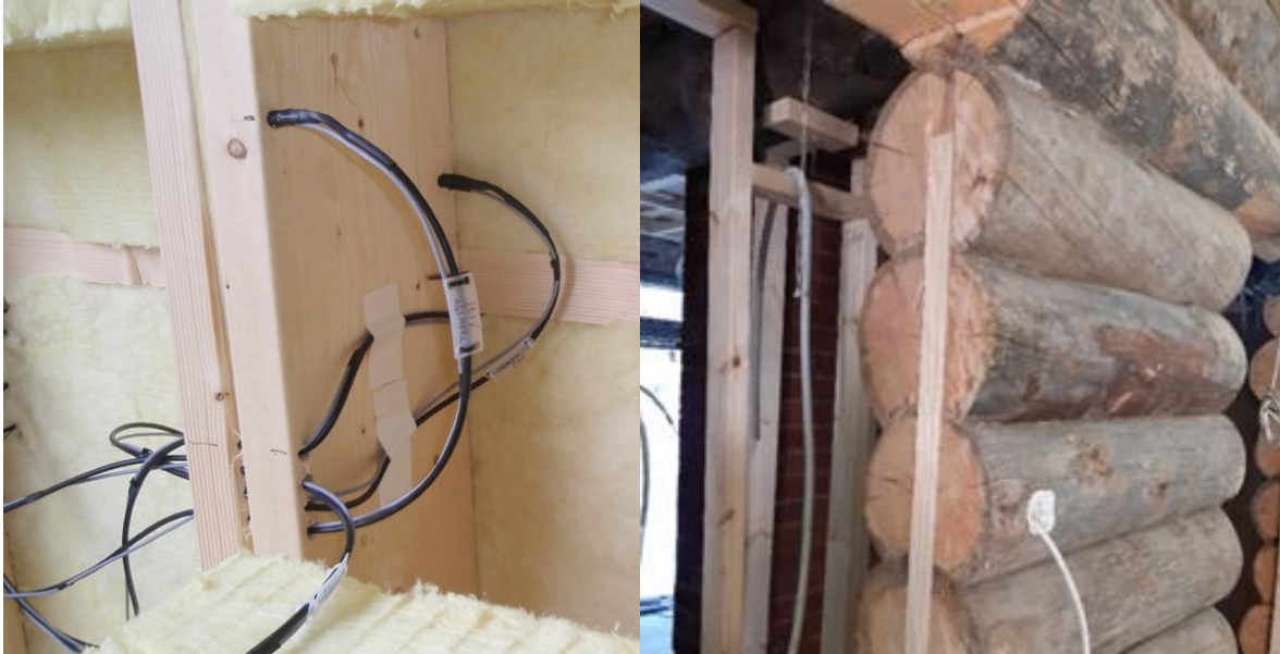
Kuva 5. Puumateriaalin ominaisuudet poikkeavat monessa kohtaa homogeenisempien materiaalien ominaisuuksista, joka on syytä ottaa mallintamisessa huomioon. Vasemmalla rakennemittausanturit seinäelementissä 11 (Kuva, Mika Palosaari), oikealla hirsirakennuksen oviaukko (Kuva, Tiina Vainio-Kaila).
