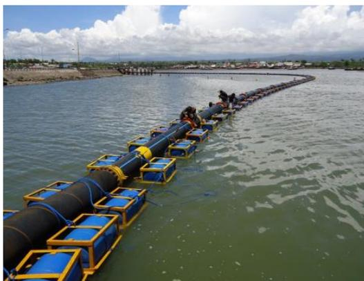
Gambar 2. 8 Pipa HDPE digunakan untuk saluran discharge slurry kapal keruk CSD
