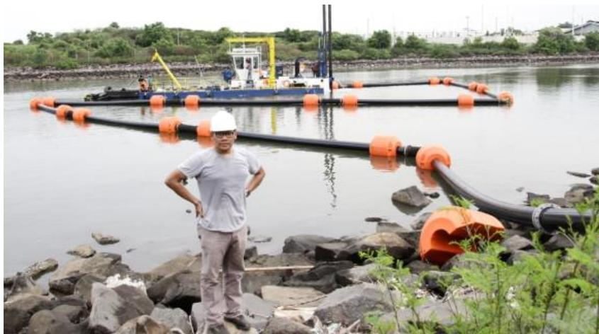
Gambar 4. 3 Pipa *discharge* apung yang terpasang di *canal water intake* PLTGU Grati
